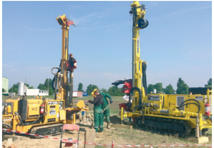
Talajmechanika, környezetvédelmi talajfúrások teljes körű kivitelezése
