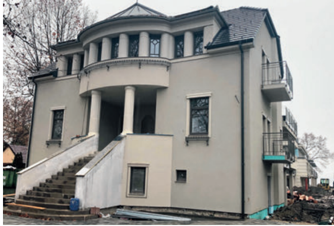
A balatonboglári Villapark felújított, bővített villaépülete
