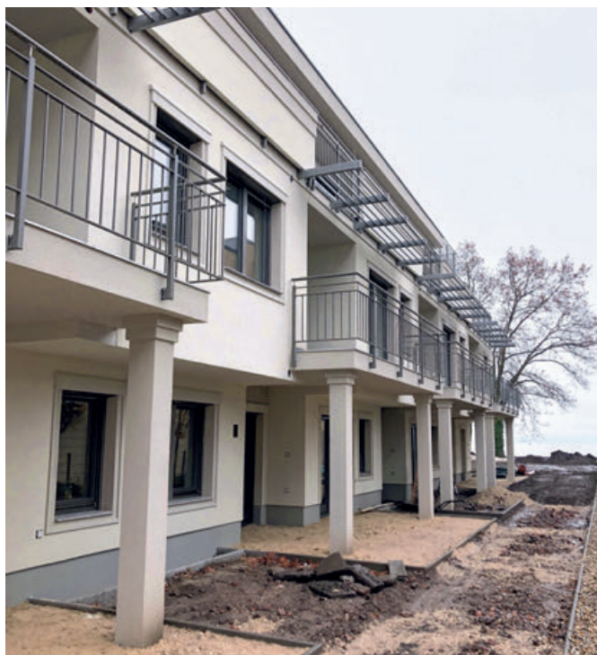
Az új teraszházból is gyönyörű kilátás nyílik a Balatonra
